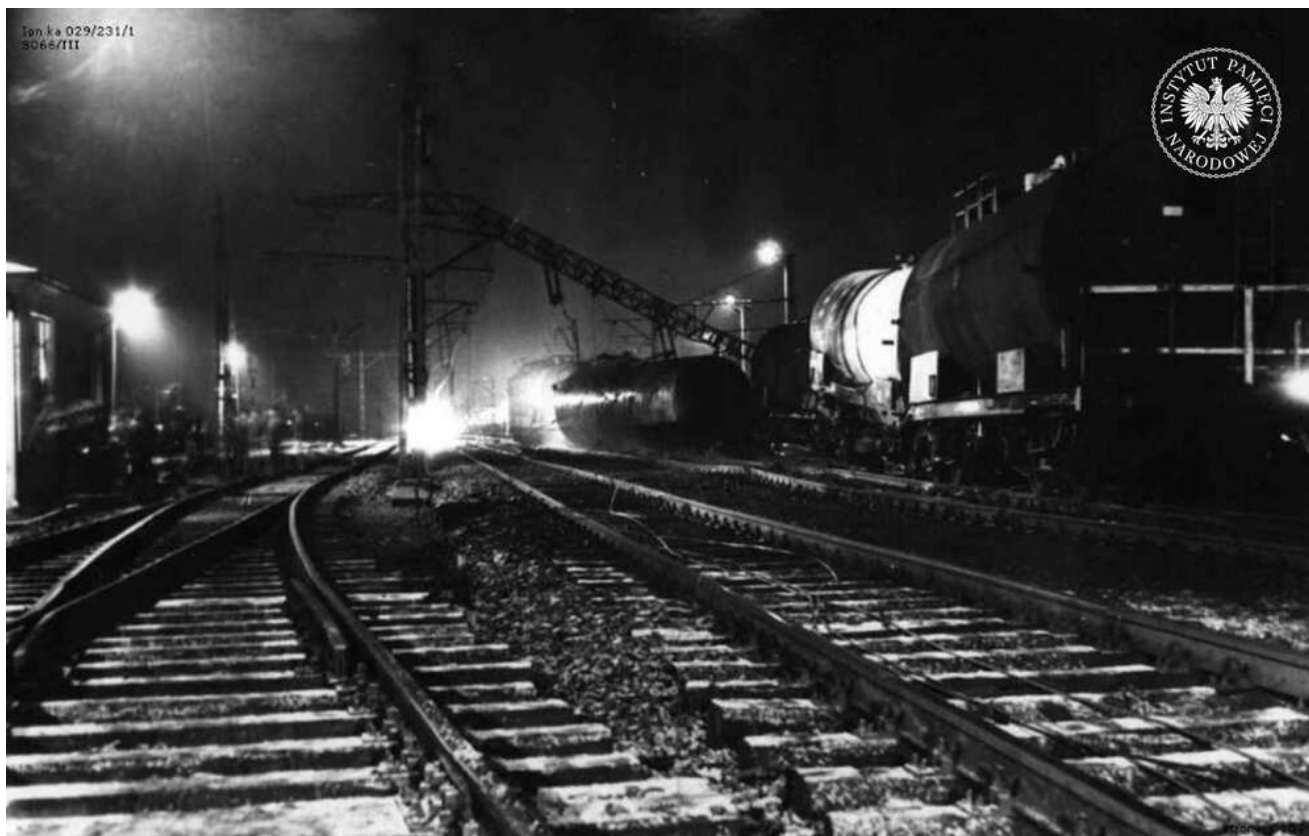
Wykolejone i uszkodzone cysterny oraz zerwana sieć trakcyjna w Poraju, grudzień 1970 r. (IPN Ka 029/231, t. 1)
