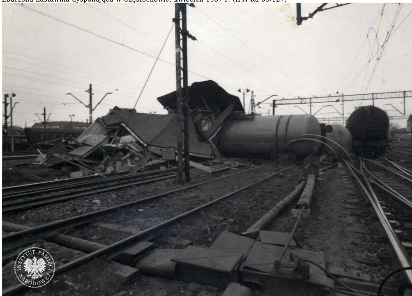
Wykolejone cysterny i zburzona nastawnia w Częstochowie, kwiecień 1987 r. (IPN Ka 029/127)
