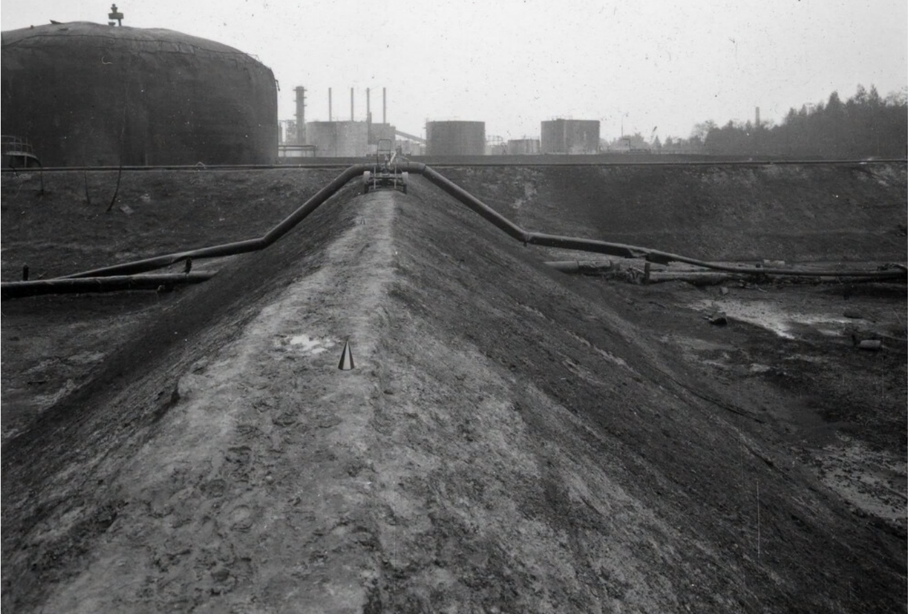
Obwałowania wokół zbiorników 251 i 254, fotografia zrobiona 13 VII 1971 r. (IPN Ka 093/299)
