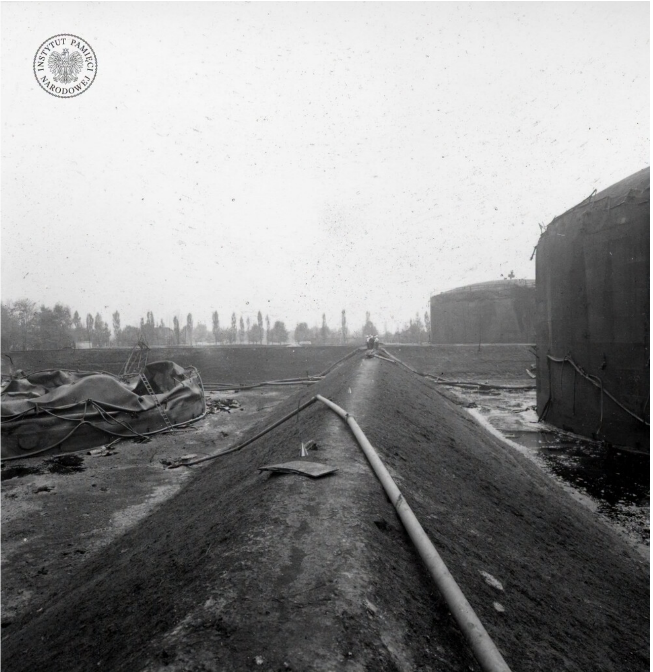
Obwałowania wokół zbiorników 251 i 254, fotografia zrobiona 13 VII 1971 r. (IPN Ka 093/299)
