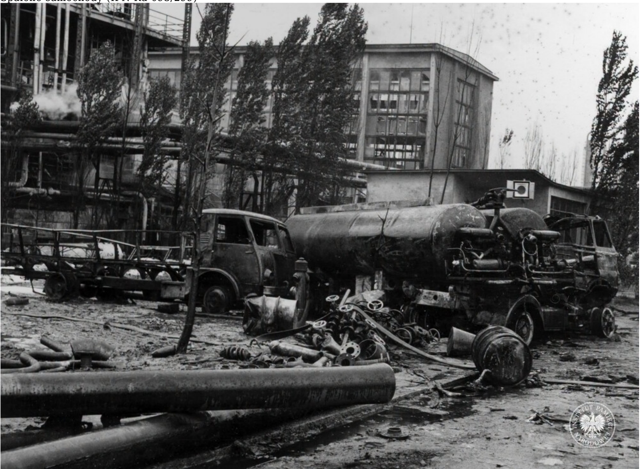
Spalone samochody (IPN Ka 093/299)
