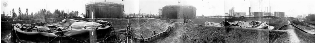
Obwałowania wokół zbiorników 251 i 254, fotografia zrobiona 13 VII 1971 r. (IPN Ka 093/299)
