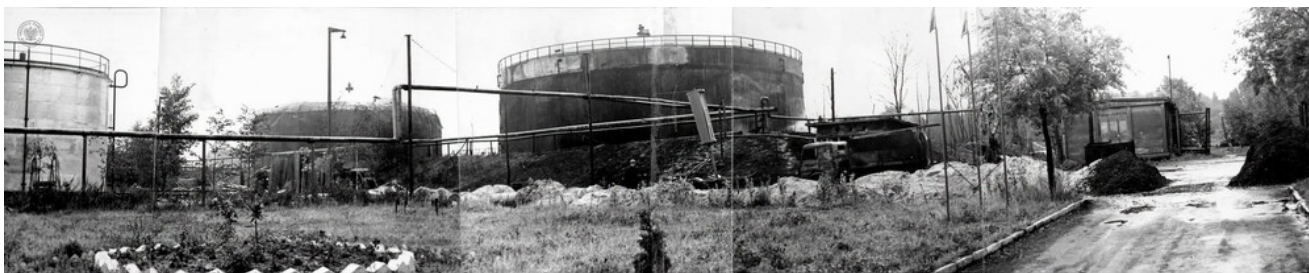
Obwałowania wokół zbiorników 251 i 254, fotografia zrobiona 13 VII 1971 r. (IPN Ka 093/299)
