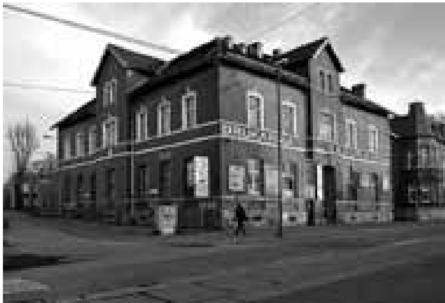
Budynek restauracji Kowollików przy Dorotheenstrasse (dziś ul. 3 Maja) 82; w 1939 r. punkt werbunkowy do Freikorpsu . Stan obecny
